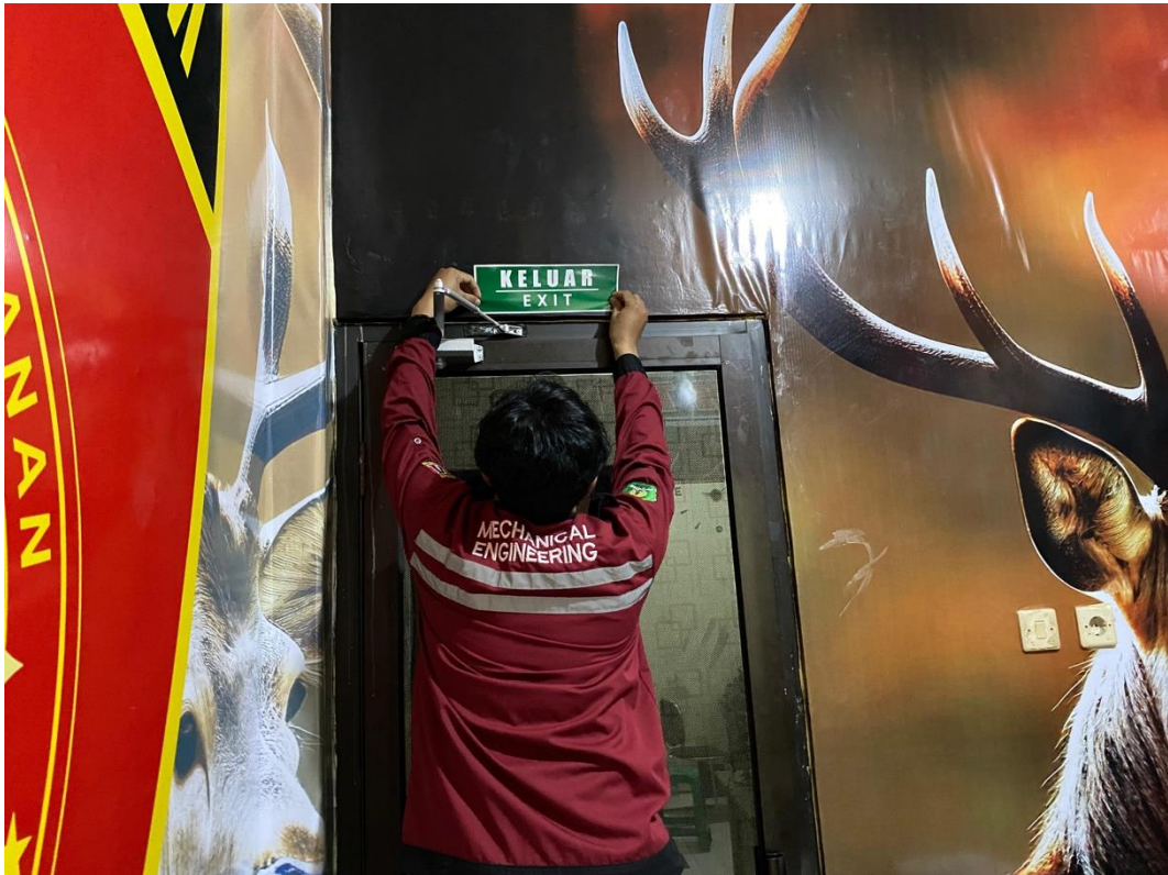
Pemasangan Rambu Keluar Pada Ruang Kanit Intelkam
