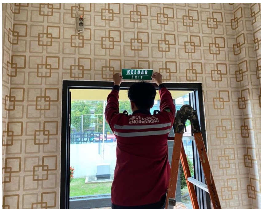
Pemasangan Rambu Keluar Pada Pintu Utama Polsek Lantai 1
