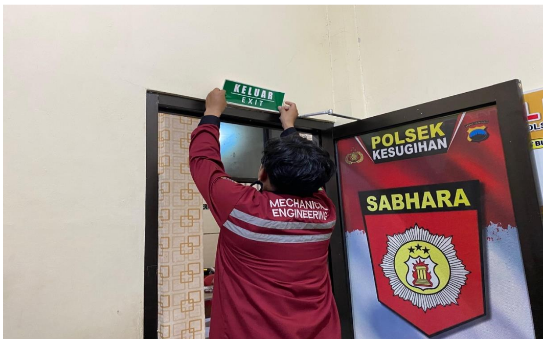
Pemasangan Rambu Keluar Pada Ruang Kanit Sabhara
