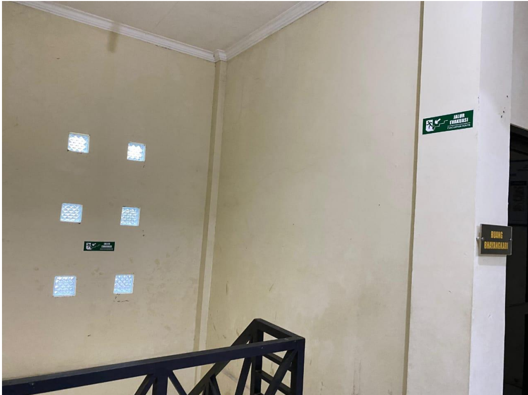
Pemasangan Jalur Evakuasi Pada Lantai 2
