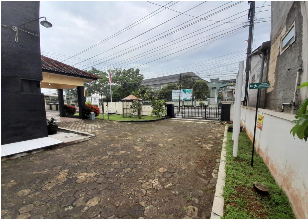
Pemasangan Jalur Evakuasi Pada Lantai 1
