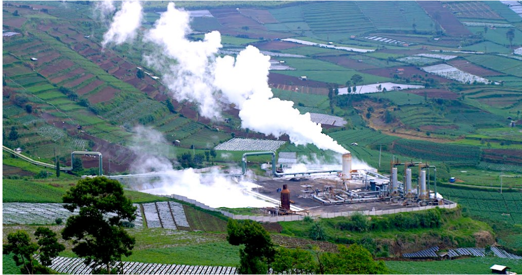
Gambar 8. Pembangkit listrik tenaga panas bumi di Dieng (Courtesy: thinkgeoenergy.com)
