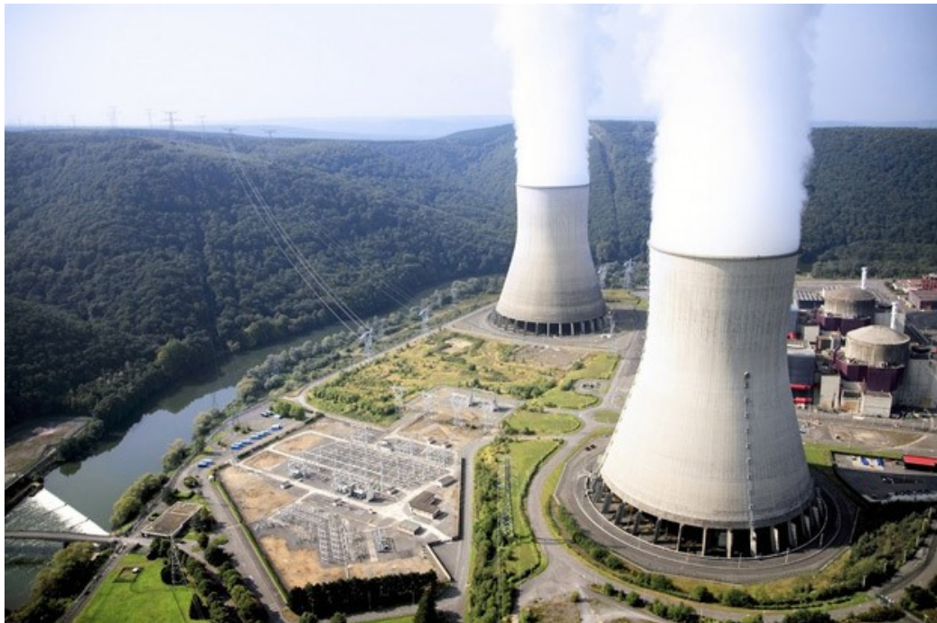
Gambar 12. Pembangkit tenaga nuklir di Perancis (Courtesy: international.sindonews.com )
