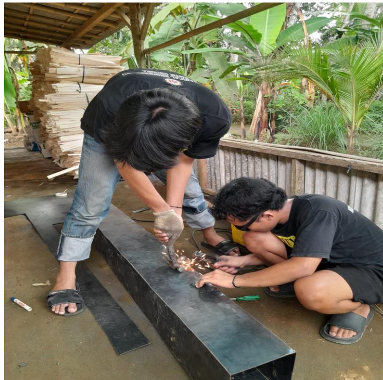
Proses pengelasan plat besi persegi/inlet
