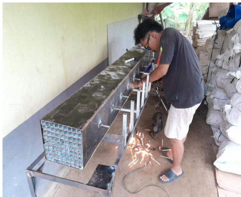
Pembuatan serta pengelasan segmen dan pipa penampang
