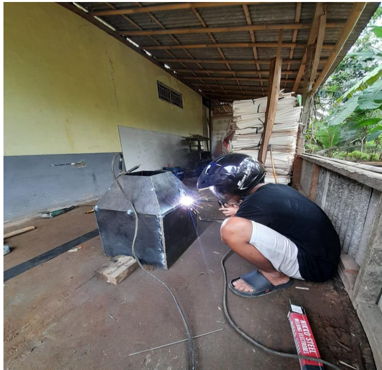
Proses pengelasan rumah blower/outlet
