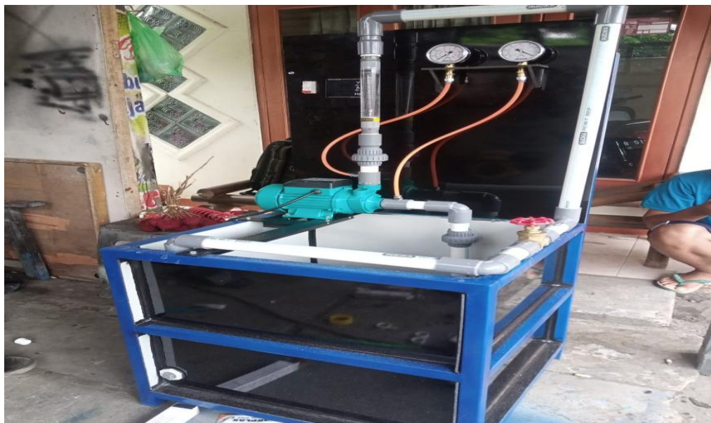
Lampiran 5 Proses pemasangan pipa paralon, pressure gauge , vaccum pressure , MCB , digital meter , pembuangan air
