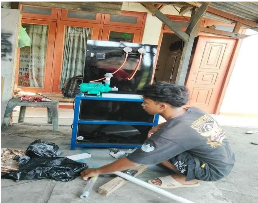
Lampiran 6 Proses perakitan pompa dan pipa
