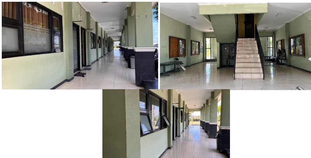
Gambar 7. Kondisi Eksiting Lantai 1
