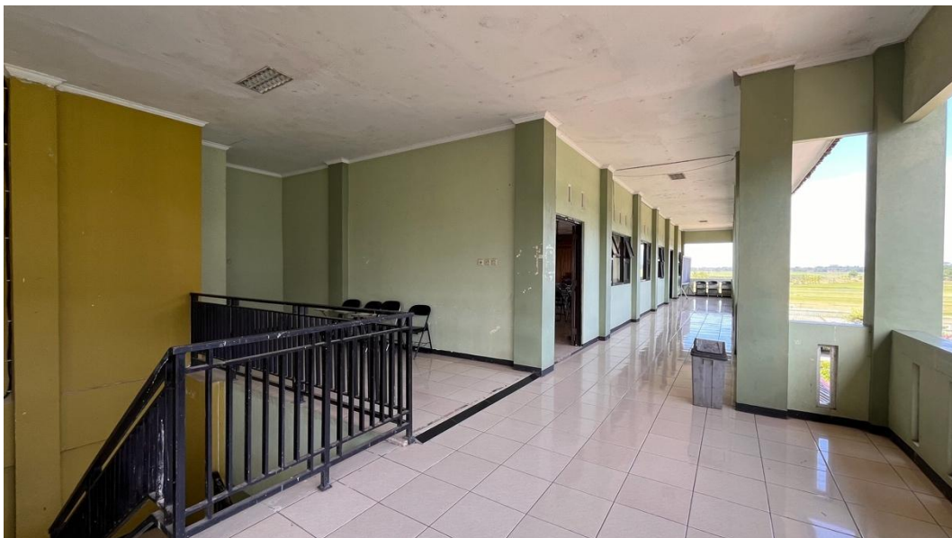
Gambar 8. Kondisi Eksisting Lantai 3
